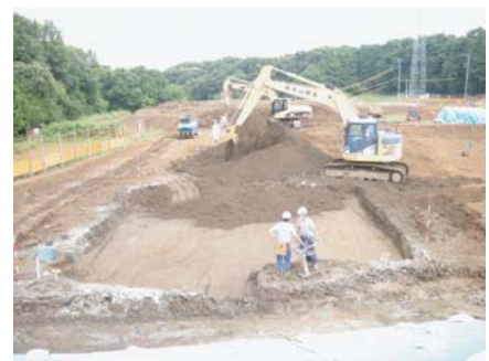
⑤改良した土の埋め戻しは50 cmずつ2回に分けて締め固め万全を期す
