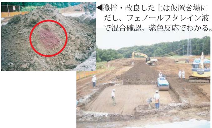
⑤改良した土の埋め戻しは50 cmずつ2回に分けて締め固め万全を期す
