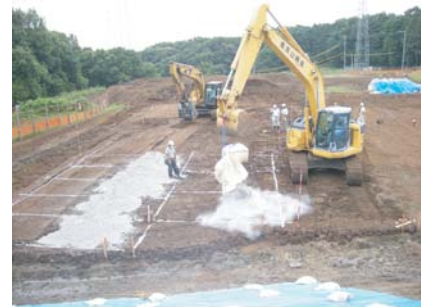
②セメント系固化材の散布
