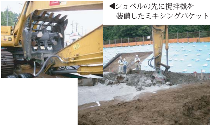
③表土と固化材の攪拌・混合
